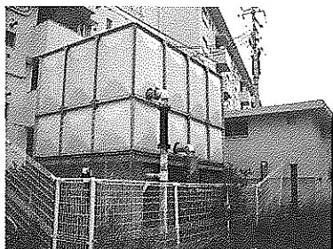
地震によりパネルの継ぎ目より漏水
