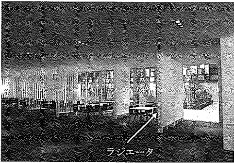
写真-4 放射空調用ラジエータ
