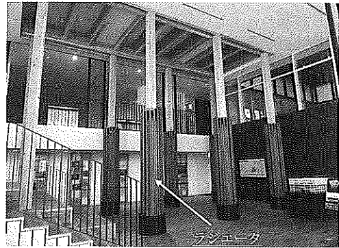
写真-3 チューブ型放射空調用ラジエータ
