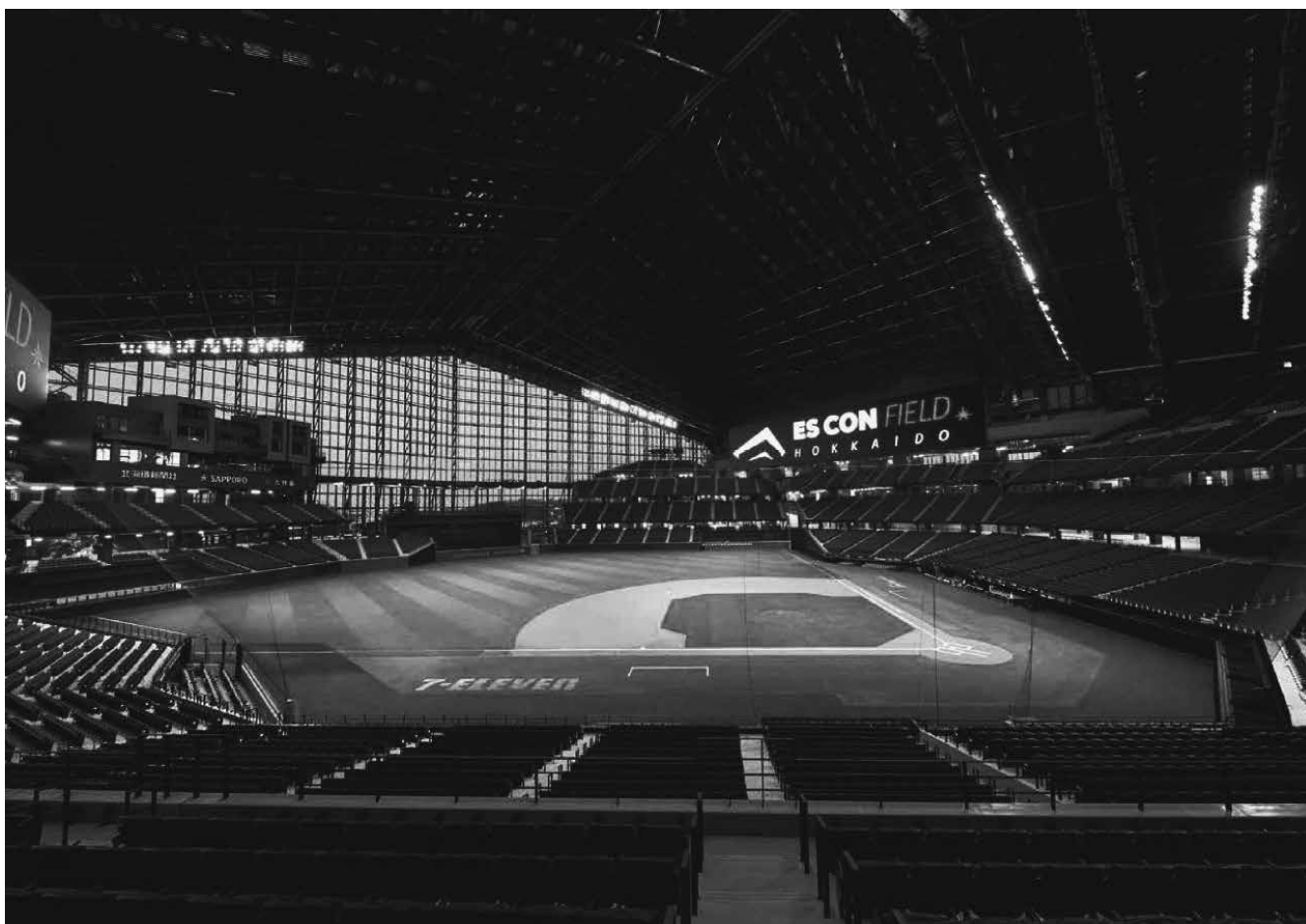
354台のLED投光器による照明が天然芝を照射
