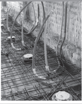
スラブ内配管 (さや管+ポリブテン)
