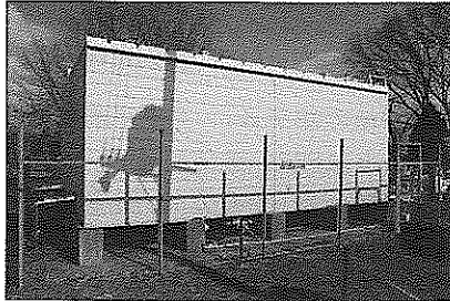
写真1 岩手県一関市内(震度6弱) 国立病院120m3 受水槽 断熱+サイディング仕様 被害なし
