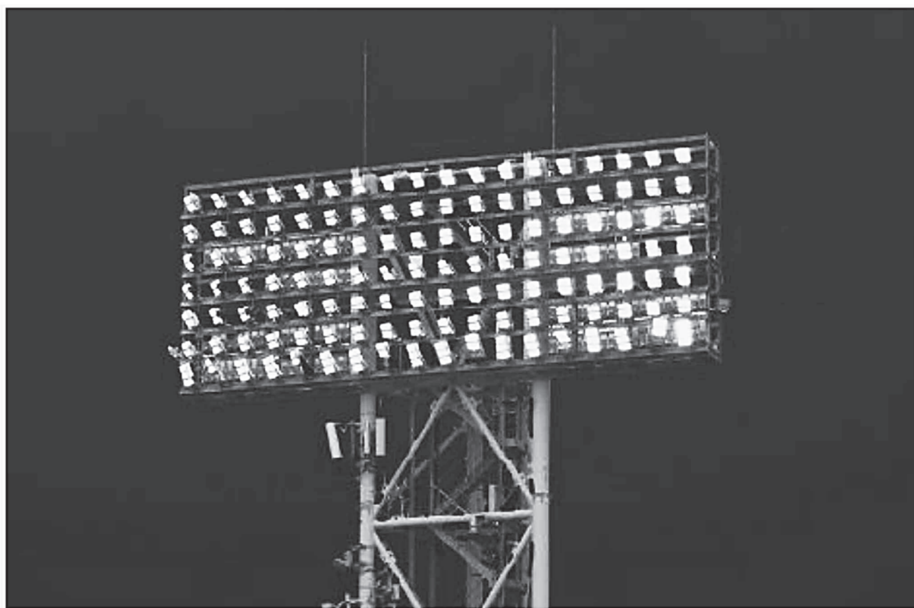
(写真2) 従来のカクテル光線をLEDで再現した鉄塔照明
