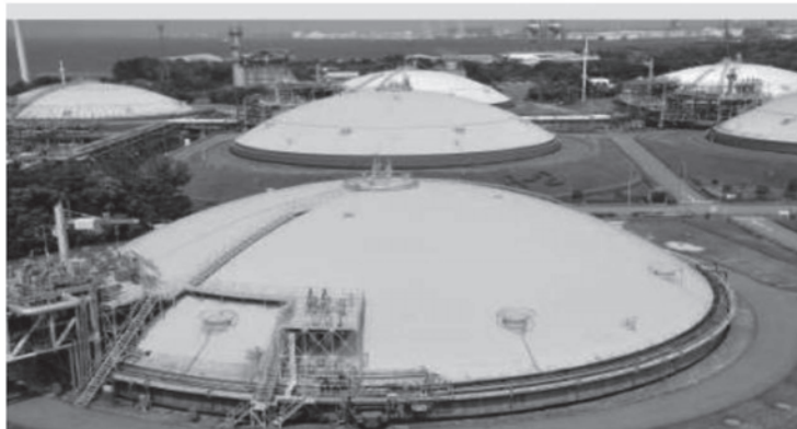
LNGタンク外観
