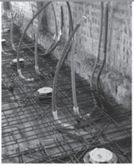
スラブ内配管（さや管+ポリブテン）
